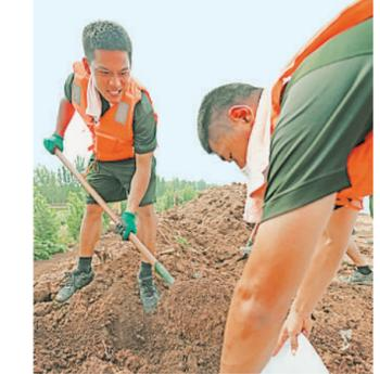
8月11日,武警第一机动总队某支队官兵在抢险现场装填用于加固堤坝的沙袋。在天津市静海区王口镇千里堤、苗头排干西堤加固抢险一线,武警第一机动总队官兵争分夺秒加固险要堤坝,切实维护群众生命安全。新华社发
