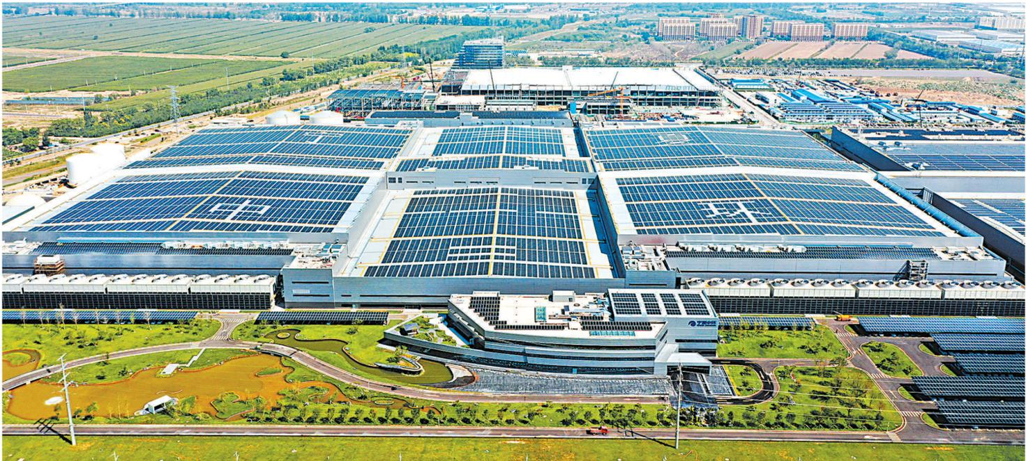
8月13日,记者航拍的TCL中环宁夏产业园新增四期5.67MW分布式光伏项目。目前,该项目已全容量并网发电。中环宁夏产业园分布式项目装机容量30MW,采用TCL中环G12高效叠瓦组件,年平均提供绿色电量3931.54万千瓦时,相当于节约标准煤量约1.57万吨,减少二氧化碳排放量约3.92万吨、二氧化硫排放量0.12万吨、氮氧化物排放量0.06万吨,等同于植树169.06万棵。该项目的并网发电,使得宁夏晶体生产基地的绿色使用比例达50%。
