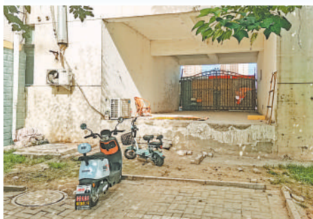
人员疏通通道设置高台,铁栅门紧闭。
