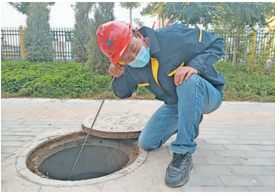
宁夏水投集团供水工人“听诊”供水管网漏损情况。(图片由受访单位提供)
