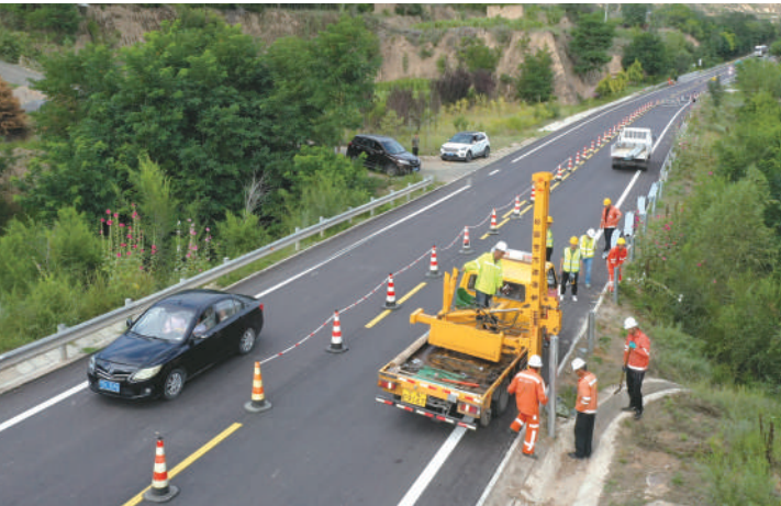
在急弯陡坡及临水临崖路段安装护栏板,扎实推进全区公路安全生命防护提升工程。
