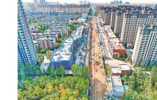
9月26日,银川市雨污管网海绵化改造工程烟墩巷(大有巷—宝湖路)段正在进行全封闭施工。据了解,烟墩巷雨污管网海绵化改造工程项目包括建设道路、涵洞、给水、再生水、排水工程以及道路附属工程等。本报记者 马楠 王洋 摄
