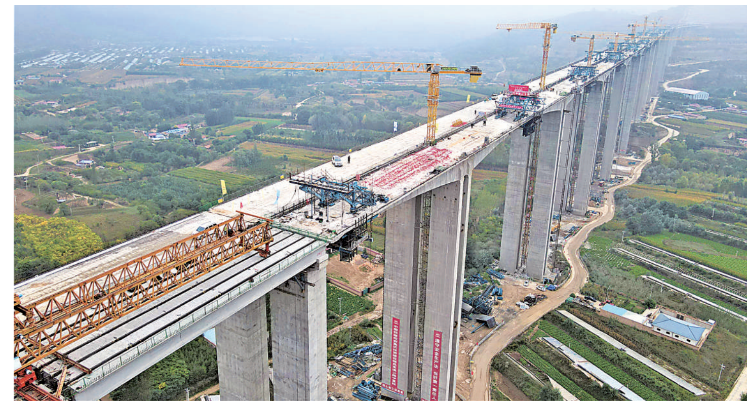
9月30日,银昆高速公路友联红河特大桥顺利合龙。
