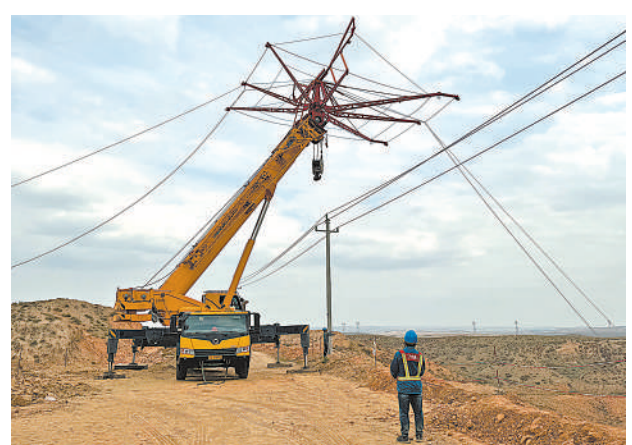
10月12日,在吴忠朱梁—牧园35千伏线路工程施工现场,国网吴忠供电公司首次引进并应用“移动式伞形跨越架”进行跨越障碍架设输电线路并取得成功。跨越施工是电网建设中一项高风险且具有一定难度的工作。过去,跨越施工先搭设钢管脚手架跨越架,需耗时2天,而“移动式伞形跨越架”使用吊车辅助安装只需1小时。而且实现不停电、不完全封路、远程遥控操作、无人员高空与近电作业,跨越架架设和撤除均可快速完成,施工效率、安全保障进一步提高。本报记者 马越 摄
