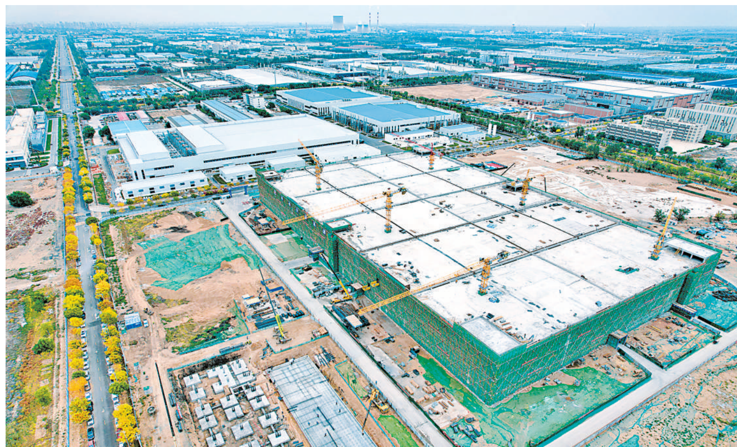
10月12日,位于银川经济开发区的宁夏晶钰新材料科技有限公司年产10000万千米全刚线项目建设正在加速推进。该项目总投资30亿元,占地面积305亩,总建筑面积19.5万平方米,分两期建设。全面建成后将形成年产10000万千米全刚线的规模,新增产值50亿元以上,新增就业岗位1400余人。
