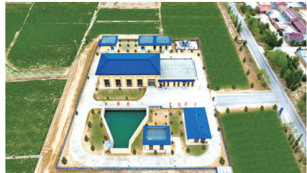
中部干旱带海原西安供水水源工程关桥二泵站。
