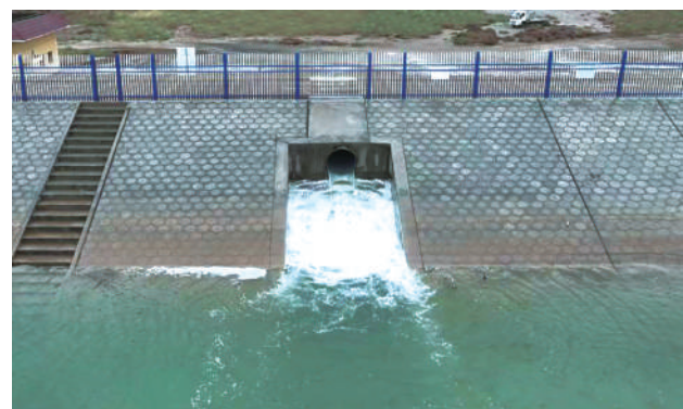
中部干旱带海原西安供水水源工程9号蓄水池通水。
