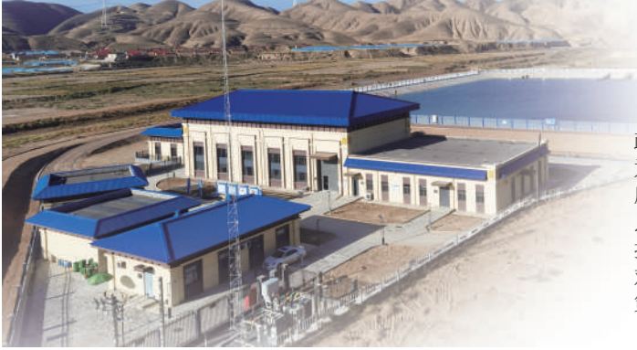
中部干旱带海原西安供水水源工程王家湾泵站和蓄水池。
