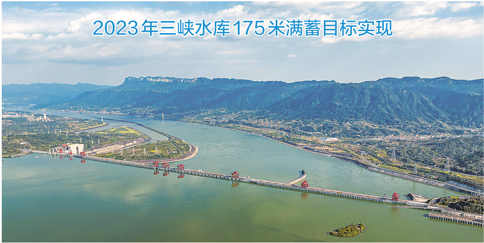
10月20日在湖北省宜昌市秭归县茅坪镇拍摄的水位上涨后的三峡水库。记者从水利部了解到,三峡水库坝前水位20日13时达到175米,标志着2023年三峡水库实现满蓄目标,将有力保障今冬明春长江流域供水、发电、航运、生态等需求。
