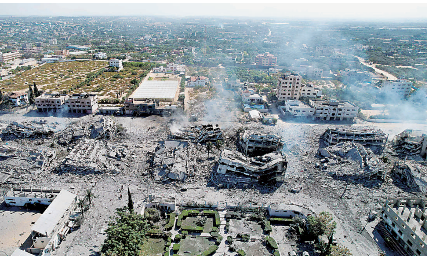
这是10月20日在加沙地带扎赫拉拍摄的以色列军队轰炸后的建筑废墟。
