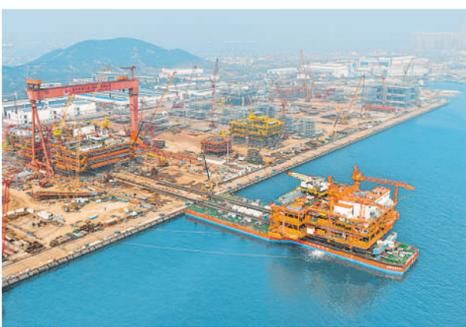
10月26日在青岛建造现场拍摄的埋北油田中心平台。平台装船后将赴渤海西部海域,进入海上安装和调试阶段。10月26日,埋北油田中心平台在山东青岛完工装船,这一油气处理与岸电设备共建平台总重量近15000吨,将高压输电设备与油气处理模块建在同一平台上,实现岸电的引入,这是该模式在国内的首次尝试。 新华社发
