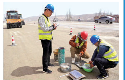
施工人员进行公路质量检测。
