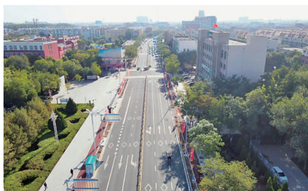
银河路（109国道—银新干沟）排水防涝系统改造工程比计划提前了60个工作日竣工通车。
