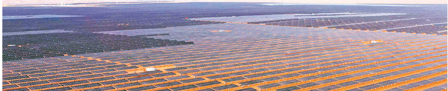
中卫腾格里沙漠3吉瓦新能源基地光伏复合项目首期100万千瓦光伏项目。
