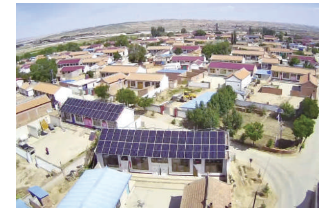
创维光伏金装房
