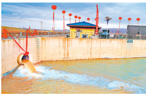
中部干旱带海原西安供水水源工程通水。
