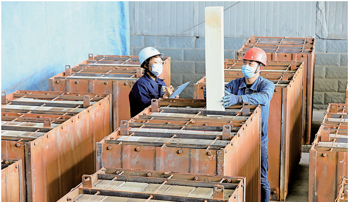
11月12日,宁夏共宣环保科技有限责任公司,工作人员正在检查经过再生的废旧脱硝催化剂。目前,该公司已建成失效石油化工催化剂再生利用和脱硝催化剂循环再制造生产线,可实现年处置5万吨的失效催化剂循环经济产能。近年来,石嘴山市大武口区强化固废利用,截至今年8月,大武口区一般工业固废综合利用率达到30.16%,较去年全年提升12.43个百分点。
