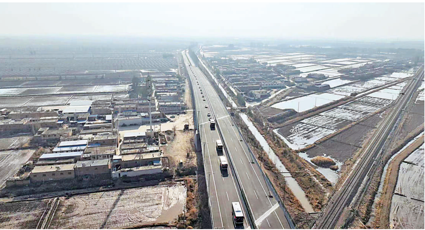
11月14日,灵胡路立交桥正式通车。灵胡路既是连接灵武与吴忠两地经济、市民生活的重要交通线,也是运输煤炭及煤化工产品的重要交通线。新建成的灵胡路立交桥为七孔桥,全长280米。
