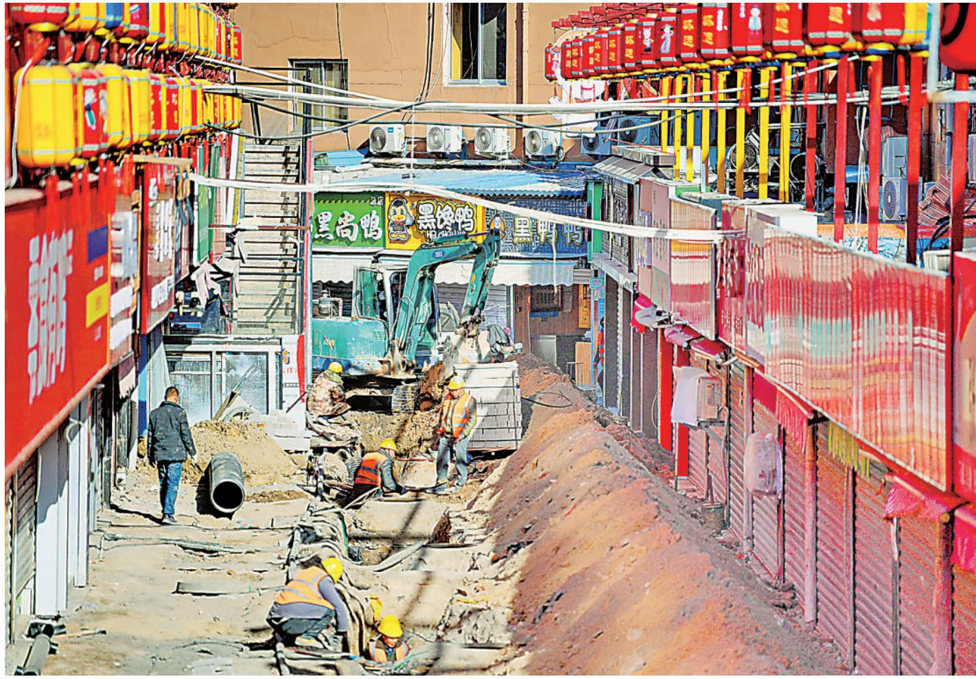
11月16日,怀远观光夜市基础设施改造项目施工现场。位于银川市西夏区的怀远观光夜市,每年吸引成千上万的游客。近年来,怀远观光夜市完成了凤还桥建设、市场外立面以及特色街区改造、红酒街提升改造,基础设施落后、交通堵塞严重等问题有了很大改观。此次基础设施改造,项目概算总投资560万元,改造内容包括市场地面铺装、室外给排水管道更换、增设隔油池、改造室外消火栓等,计划12月中旬完工。
