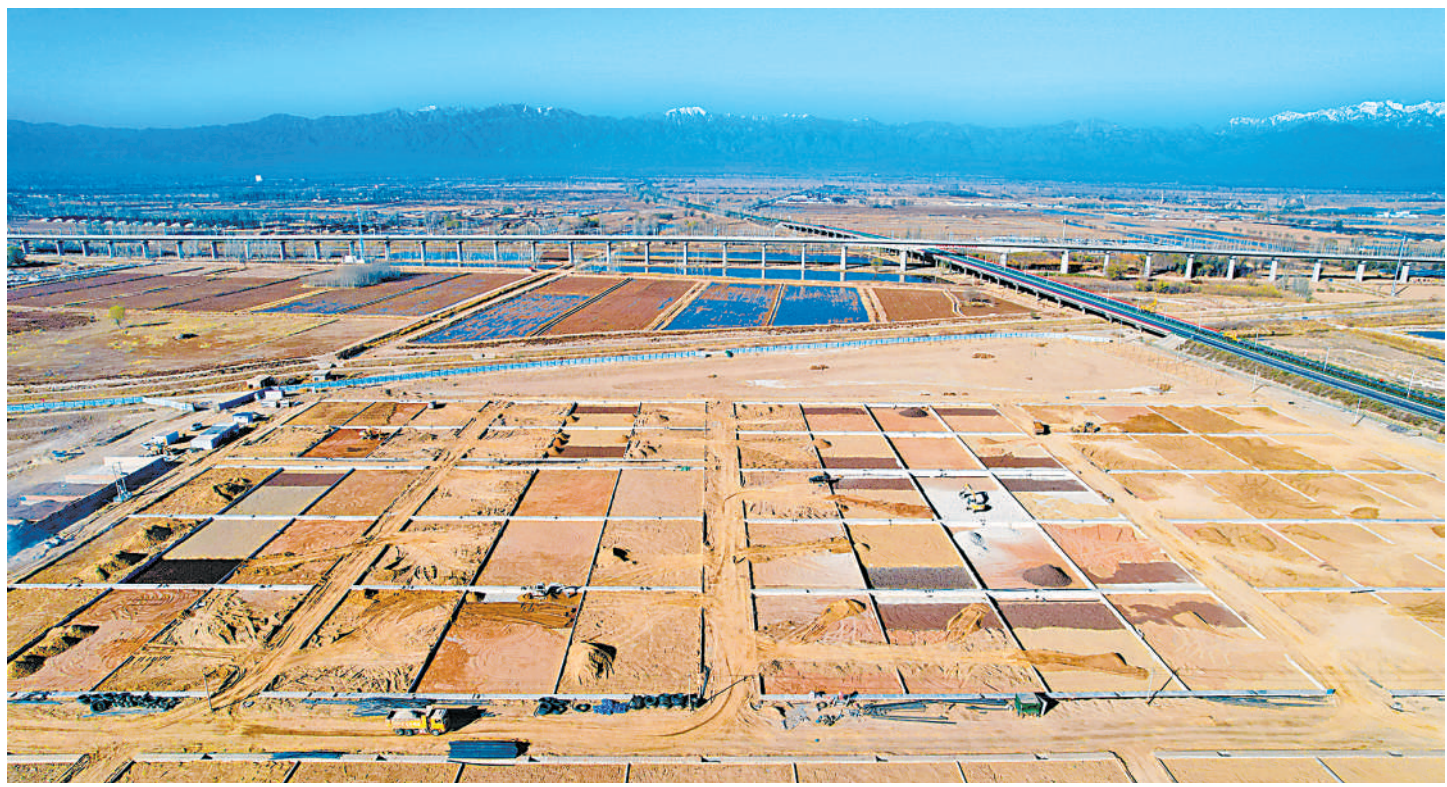
11月19日,银川市第二、第四污水处理厂片区河湖生态利用工程正加紧施工。该工程总投资13164万元,项目占地面积43.05公顷,去年开工建设,预计明年7月交付使用。届时,污水处理厂的尾水将由一级A提升至地表准IV类水,并用于典农河下游段生态补水,年节约黄河水约2000万立方米。 本报记者 马楠 王洋 摄
