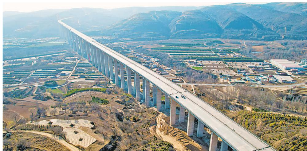
12月3日,由中铁二十局市政公司建设的银昆高速公路友联红河特大桥,犹如一条巨龙蜿蜒在山谷间。银昆高速公路LJ13-1标段项目位于彭阳县境内,总投资10.8亿元,目前,该标段线路工程已完成99%,进入主桥桥面铺装、护栏安装、绿化阶段。据了解,银昆高速公路宁夏段全线150座大中小桥梁已全部完成合龙,为明年全线通车奠定了坚实基础。本报记者 左鸣远 赵磊 见习记者 杨嘉琪 摄
