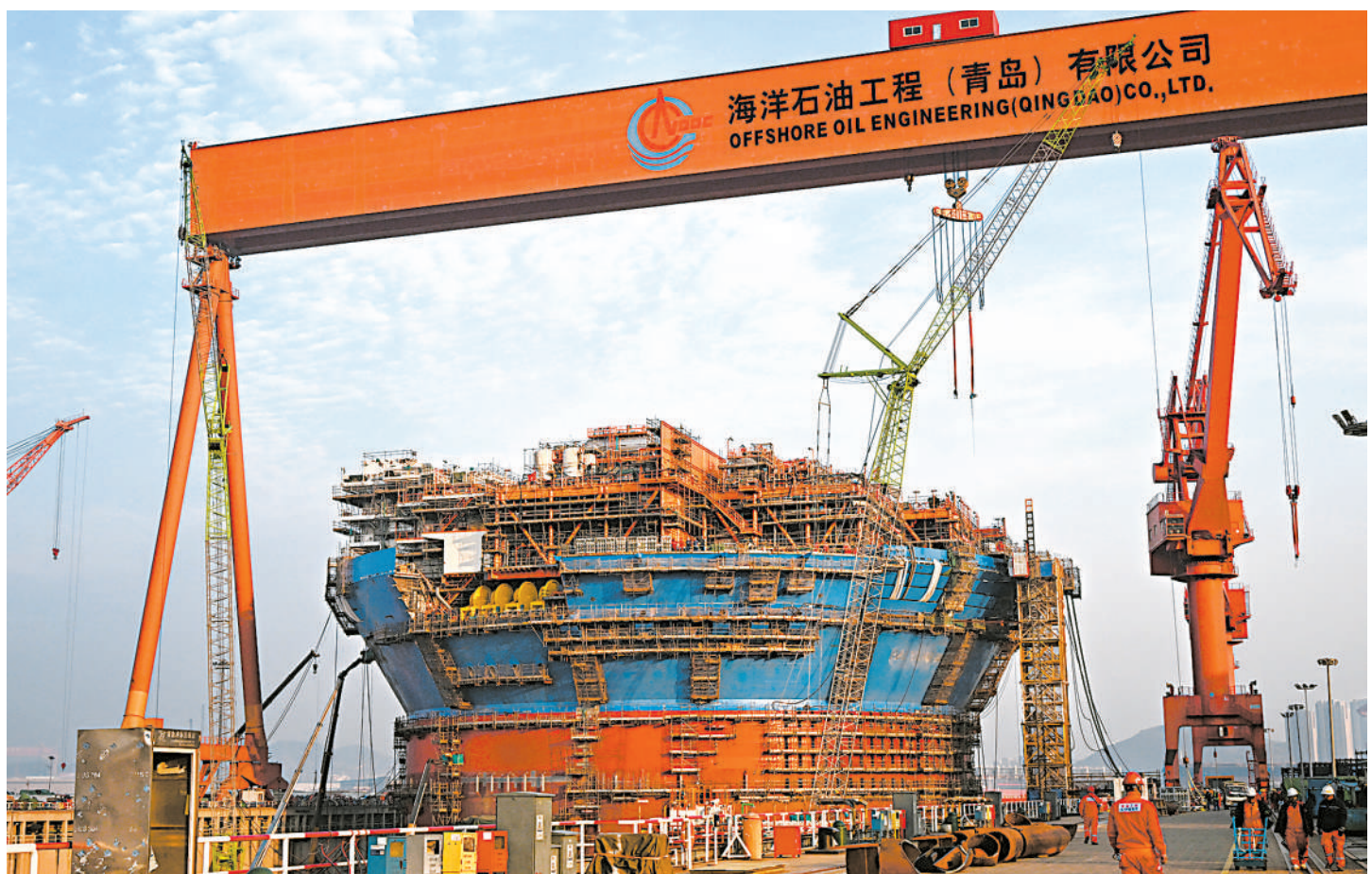
在海洋石油工程(青岛)有限公司生产基地,建造中的“海洋石油122”已显雏形。近日,由我国自主设计建造的亚洲首艘圆筒型“海上油气加工厂”——“海洋石油122”浮式生产储卸油装置(FPSO),在青岛进入最后的总装集成冲刺阶段。据介绍,“海洋石油122”船体直径约90米,设计排水量10万吨,可连续海上作业15年不回坞。 新华社发
