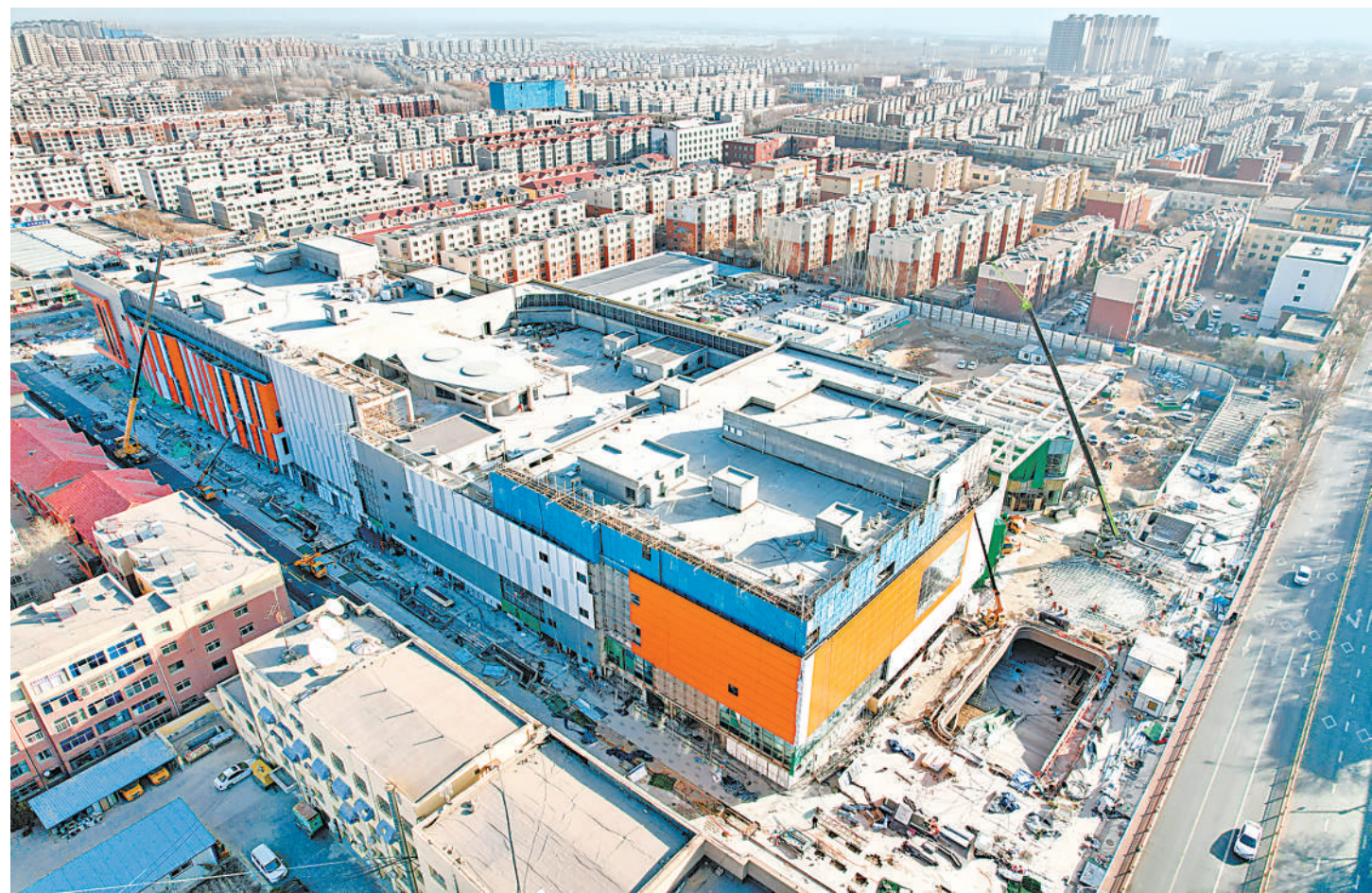
12月8日,从空中俯瞰,贺兰新百商业广场建设项目正加速推进,建筑外观已具雏形。据了解,项目总投资5.4亿元,商业规划建筑面积8.6万平方米,建成后将成为贺兰县体量最大、业态最全、配套功能最多的城市商业综合体。 本报记者 马楠 王洋 摄
