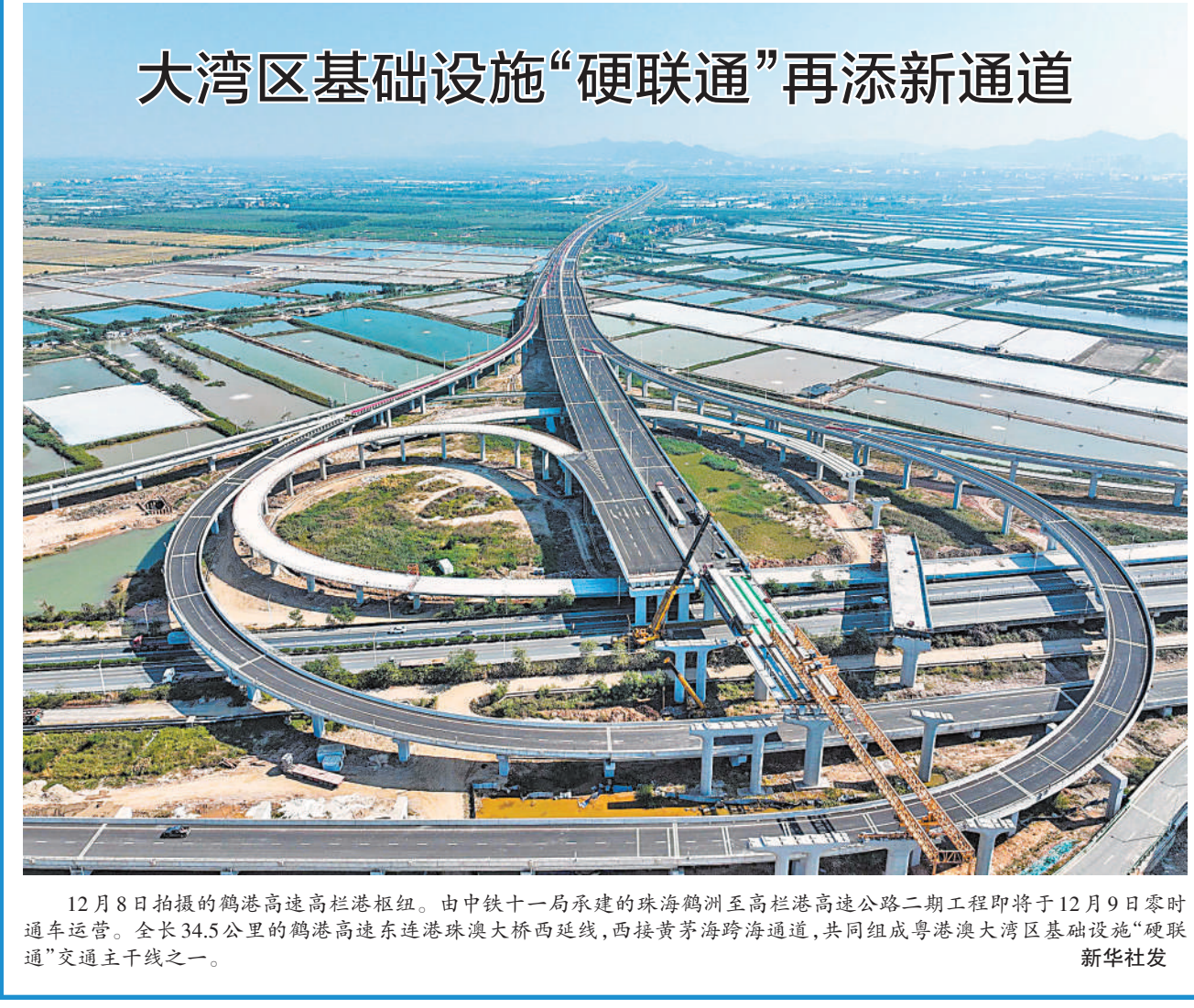
12月8日拍摄的鹤港高速高栏港枢纽。由中铁十一局承建的珠海鹤洲至高栏港高速公路二期工程即将于12月9日零时通车运营。全长34.5公里的鹤港高速东连港珠澳大桥西延线,西接黄茅海跨海通道,共同组成粤港澳大湾区基础设施“硬联通”交通主干道之一。
