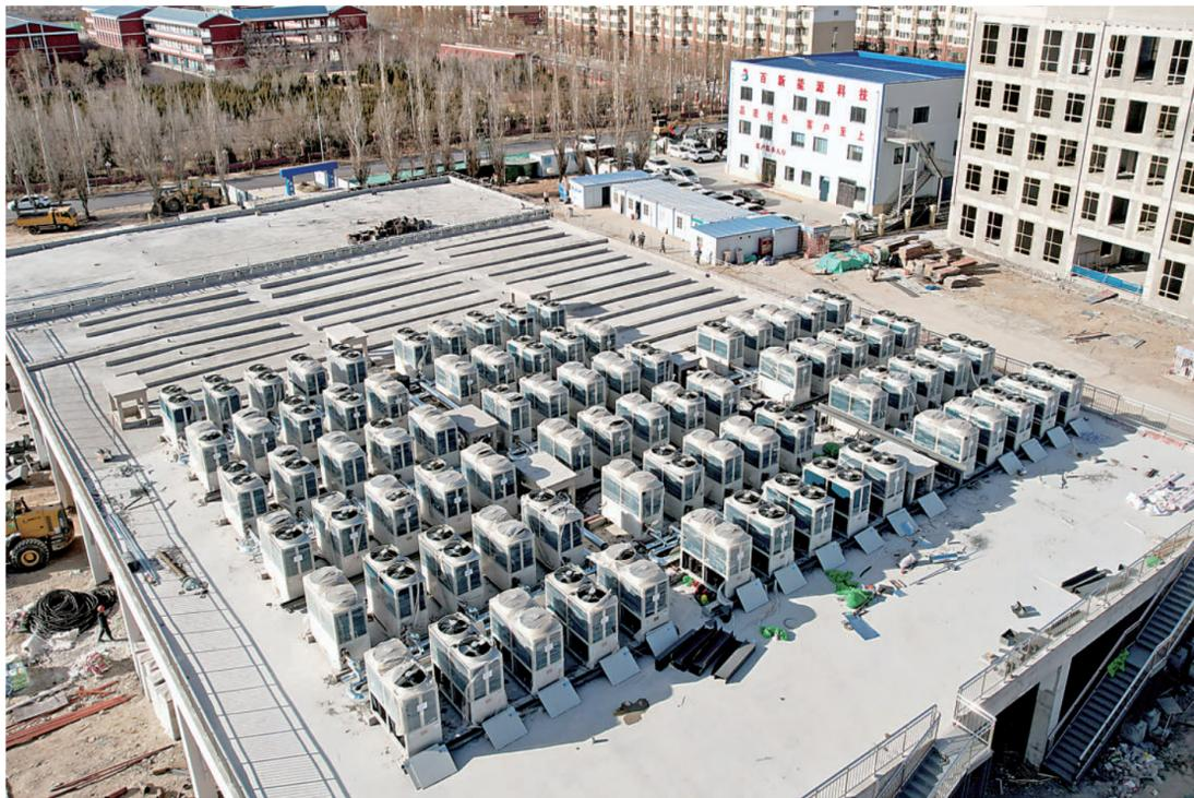
12月11日,宁夏百新能源科技发展有限公司银川北部热源厂清洁能源供热工程项目建设正在全力推进,确保月底投产运行。银川北部热源厂项目位于金凤区丰登镇丰南巷东侧、哈尔滨路北侧,占地20亩,总投资1.93亿元,是银川市清洁能源重点工程。该项目计划分两期实施,将新建清洁能源热源厂一座,新增供热面积100万平方米。今年计划完成一期建设,新增供热面积40万平方米。项目采用空气源热泵为主要热源,承担平时负荷,利用市政供热管网作为安全保障和辅助热源,供采暖天气时使用。项目建成后,将成为银川市农村地区第一座“光伏+空气源热泵”供热的大型集中热源项目,有效解决丰登片区供热能源结构单一的问题,进一步提高供热可靠性和能源利用率。 本报记者 左鸣远 摄
