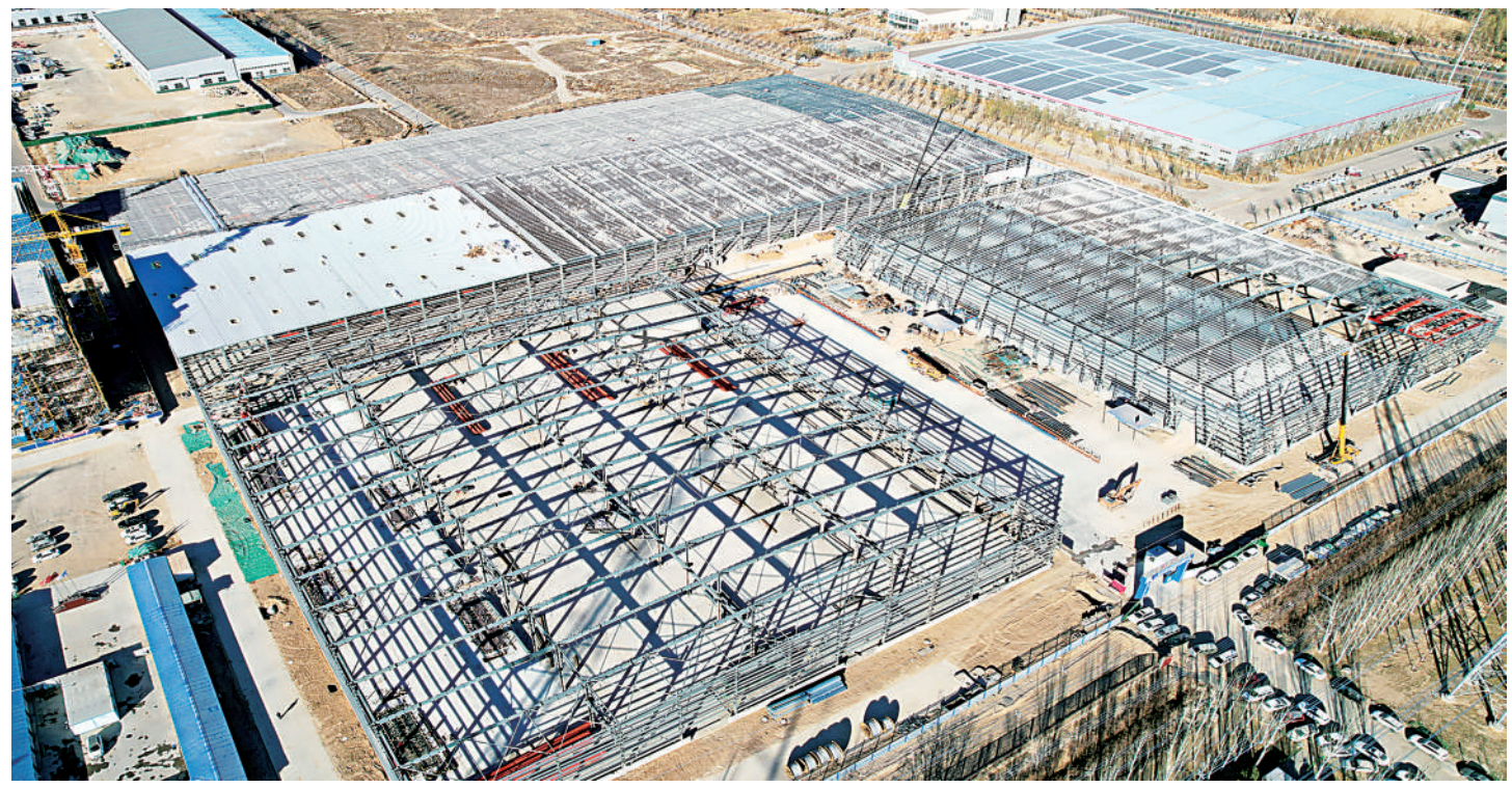
12月12日,宁夏龙祥新能源科技有限公司年产80万吨光伏支架项目正在加紧施工中。该项目位于银川经开区西区,占地面积162亩,总投资8.4亿元,总建筑面积10万平方米。计划建设光伏支架生产车间、原料库房、成品库房、辅助车间及其他配套设施,项目全部建成后将达到年产80万吨光伏支架的生产规模。
