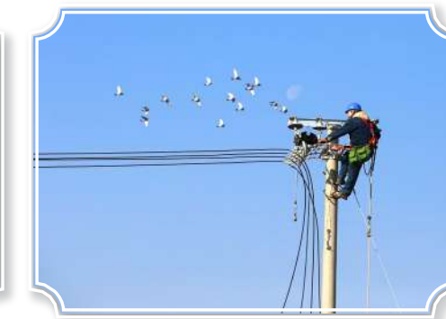
国网银川供电公司员工开展农网设备改造工作。
