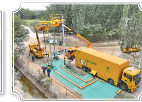
国网银川供电公司员工利用中压发电车两次并网配合开展线路检修。
