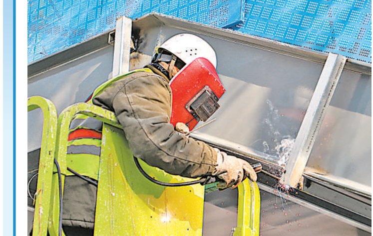
12月22日,在银川市金凤区锦苑苑小区门口施工现场,为了确保过街天桥早日通行,施工人员不畏严寒加紧施工。 本报通讯员 刘忠 摄
