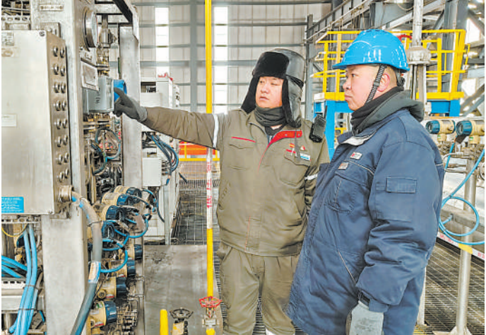
12月22日,国家能源集团宁夏煤业有限责任公司烯烃一分公司员工在认真排查装置设备运行压力数据情况,落实安全生产工作。 本报通讯员 赵寅 摄
