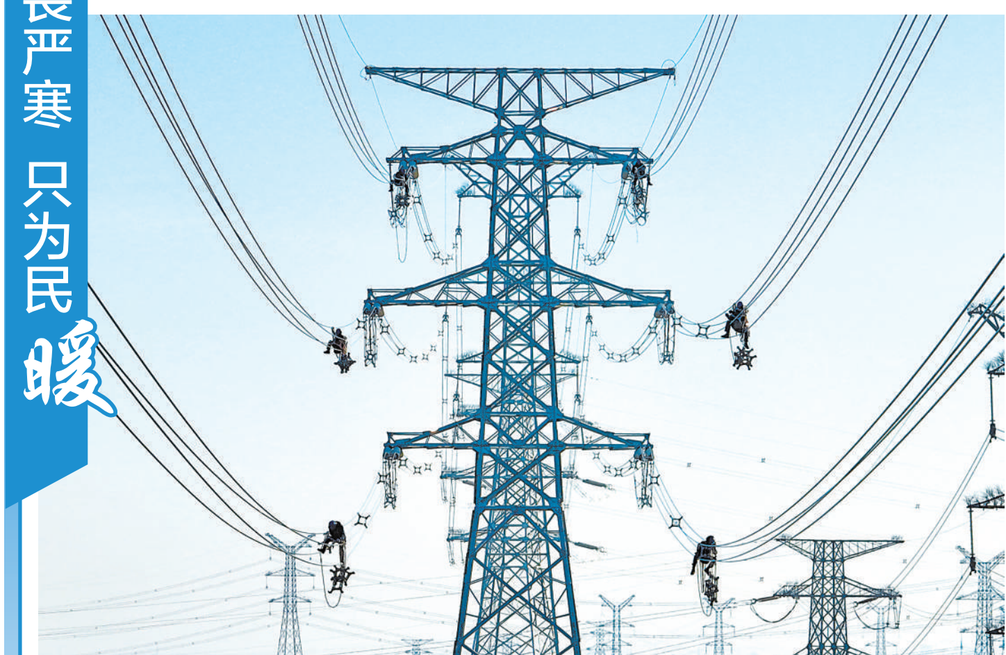
12月22日,电力工人在位于青铜峡市境内的贺兰山—典农220千伏线路工程1—4号铁塔安装间隔棒。当日,贺兰山—典农220千伏线路工程1—4号铁塔线路附件全部安装完毕。 本报通讯员 袁宏彦 摄
