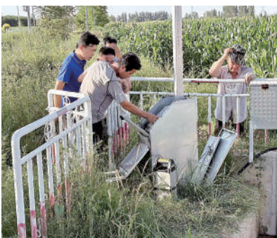
2023年春夏灌期间,宁夏水发集团工作人员维修调控一体化闸门,为农业用水户提供专业灌溉服务。吴忠市利通区引进社会资本,探索创新了现代化生态灌区“投、建、管、服”一体化新模式。(资料图片)
