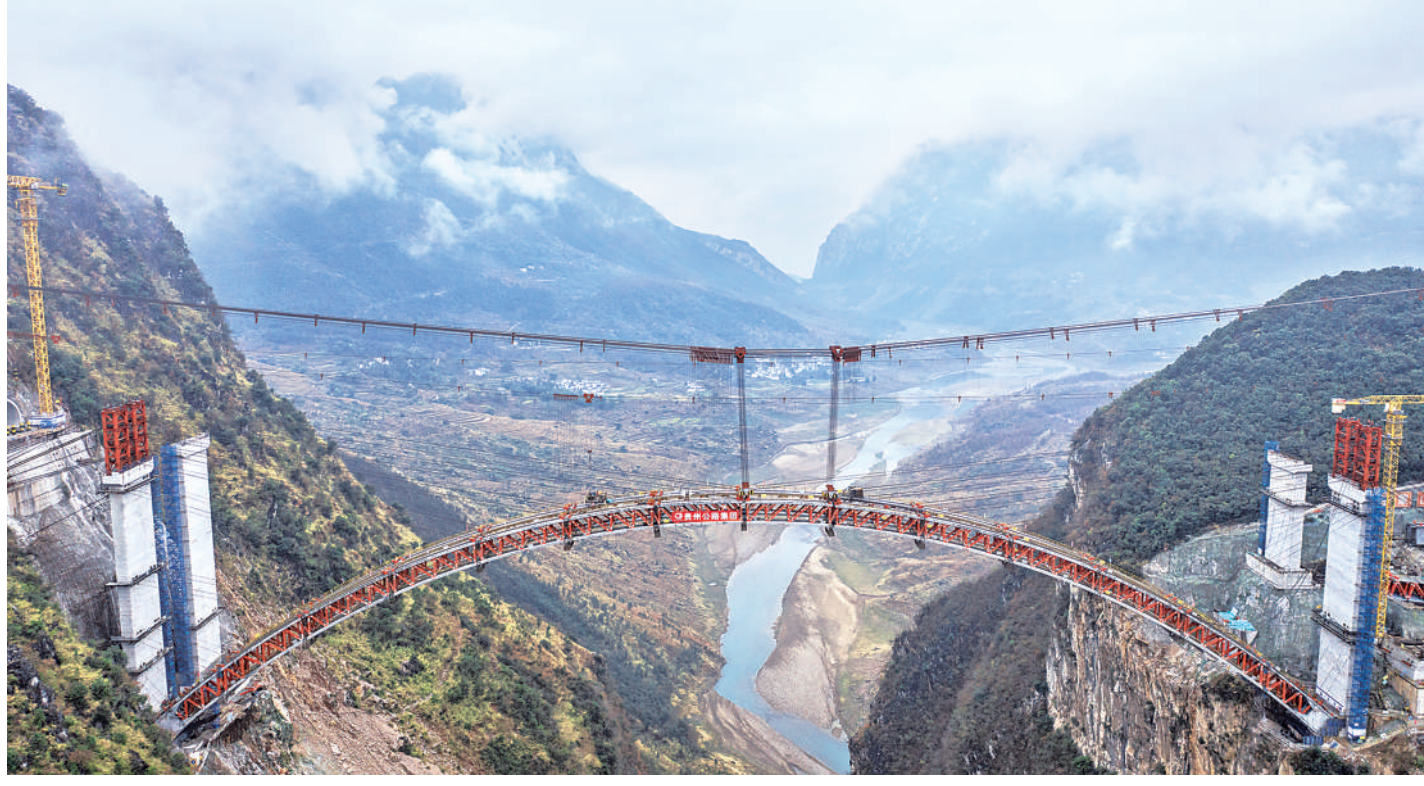
纳晴高速乌蒙山大桥主拱圈右幅顺利合龙(1月11日摄,无人机照片)。当日,随着最后一个拱圈节段完成吊装,由贵州公路集团承建的纳晴高速乌蒙山大桥主拱圈右幅顺利完成合龙。乌蒙山大桥位于六盘水市六枝特区中寨乡,是纳晴高速控制性工程之一,设计时速100公里。纳晴高速公路起于贵州省纳雍县寨乐镇,止于普安县江西坡茶厂,串联了杭瑞、厦蓉和沪昆等国家高速公路主线,不仅加强贵州省西南部南北向的交通联系,也是四川、重庆等地经贵州至云南、广西的一条重要快捷通道。
