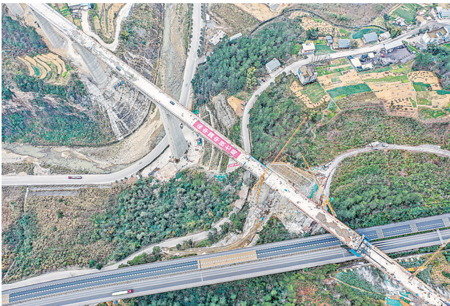
这是1月15日拍摄的石梁河双线特大桥施工现场(无人机照片)。当日,随着最后一方混凝土浇筑完成,由中铁七局集团有限公司承建的渝湘高铁重庆至黔江段石梁河双线特大桥全桥顺利贯通。石梁河双线特大桥位于重庆市武隆区,是渝湘高铁重庆至黔江段控制性工程,大桥全长936.05米,是目前国内跨度最大、墩身最高的T构高铁桥。
