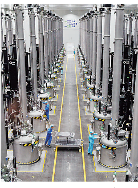
宁夏协鑫光伏5GW颗粒硅N型单晶示范项目现场,一排排崭新的单晶炉整齐排列。该项目使用的颗粒硅被誉为协鑫的“黑科技”,用于“双碳”的空间更大,成本更低。 本报记者 王鼎 摄
