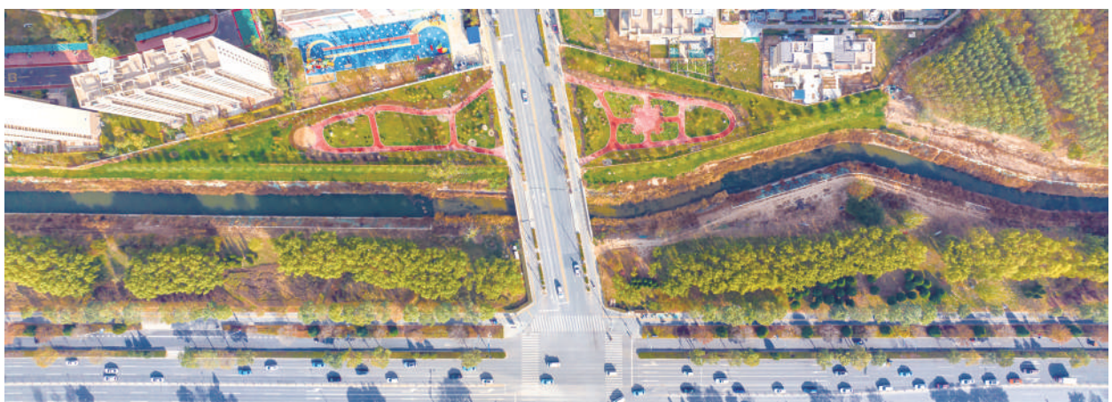
第二排水沟上段(芦苇洼注水闸—唐徕渠)治理工程。
