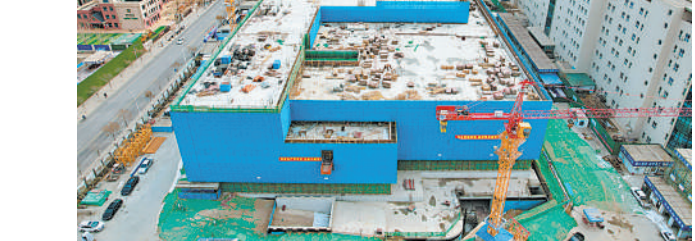
2月29日,从空中俯瞰,北京大学第一医院宁夏妇女儿童医院项目已具雏形。据了解,北京大学第一医院宁夏妇女儿童医院项目位于自治区妇幼保健院院区西北侧,西临银川市金凤区西安大街,北临盈南路。项目占地面积15118平方米,总建筑面积67870平方米。本报记者 马楠 王洋 摄
