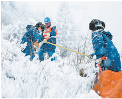
共牵一根绳防止摔倒,有序进行除雪作业。
