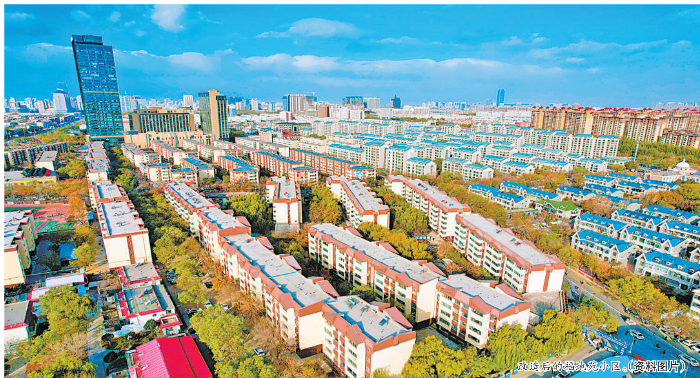
改造后的福地苑小区。(资料图片)
