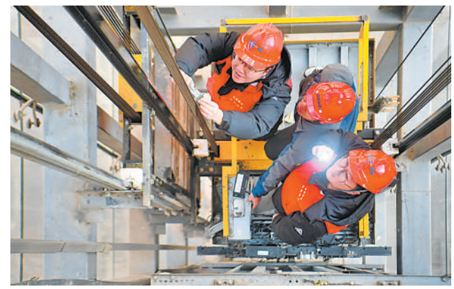
3月1日,银川市金凤区馨苑社区,志愿者检查电梯钢缆。当日,自治区市场监管局特种设备检验检测院联合开展电梯使用单位、维保单位针对小区内加装电梯免费“体检”。
