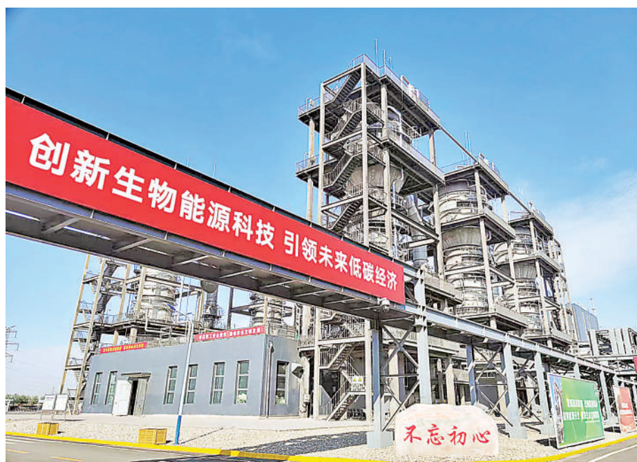
宁夏滨泽新能源科技有限公司年产6万吨铁合金工业尾气生物发酵法制燃料乙醇项目(资料图片) 本报记者 丁建峰 摄
