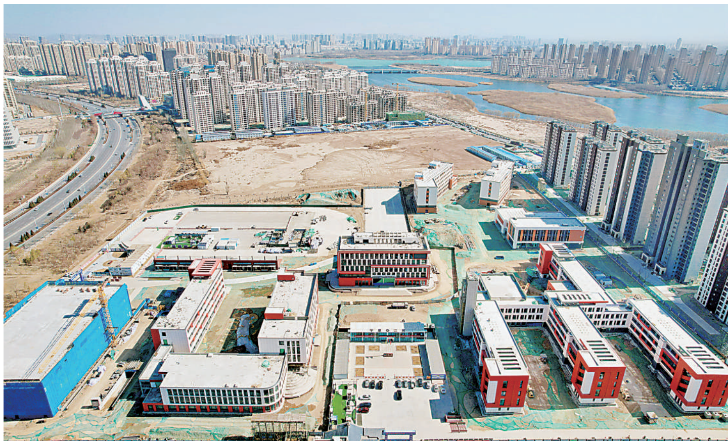
3月19日,从空中俯瞰,银川市第四十三中学项目初露芳容,现代化的教学楼与周边鳞次栉比的居民楼交相辉映。银川市第四十三中学位于金凤区正源街以东、望湖巷以北,占地面积约153.83亩。项目于2023年3月开工建设,预计今年6月竣工验收,可提供3000个高中学位。
