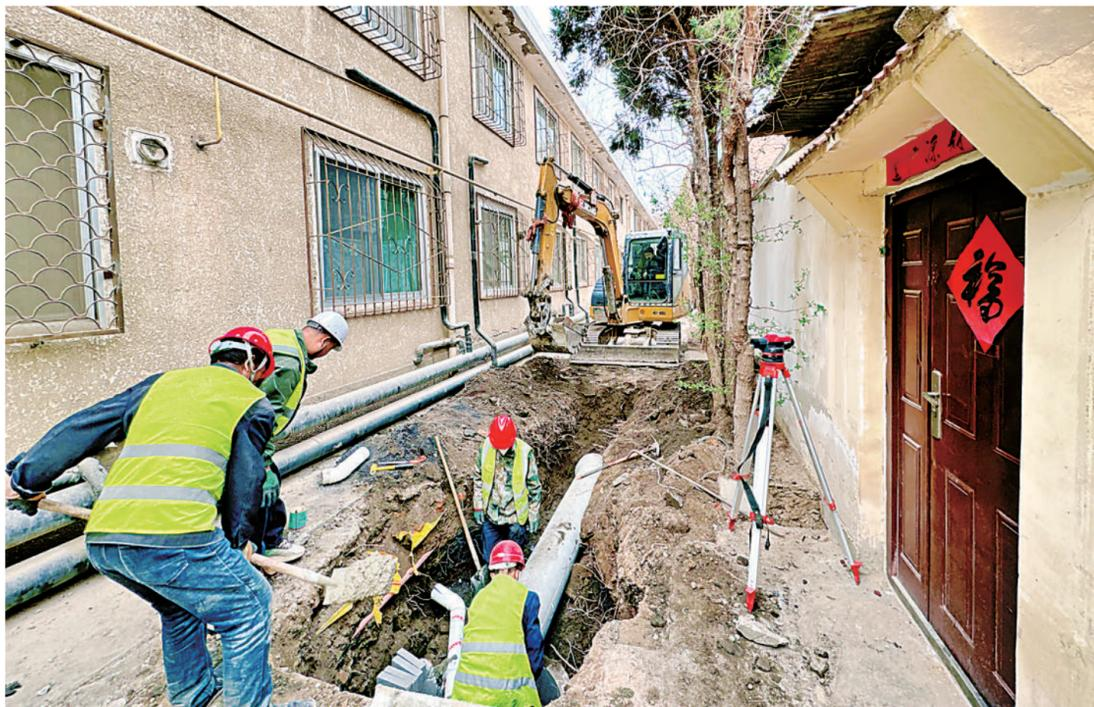
4月3日,银川市兴庆区湖滨花园小区,工人进行雨污分流管道安装。今年,兴庆区计划分两批次对104个老旧小区进行改造,涉及11个街道办事处、10808套住宅、268栋楼,建筑面积约85.25万平方米,主要实施既有居住建筑节能及室外配套基础设施改造。
