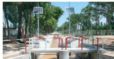
利通区全渠道自动化控制灌溉管理——东干渠二支渠测控一体化闸门。
