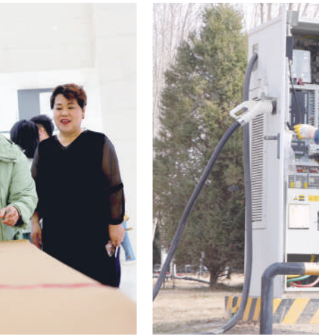
“五一”假期即将到来,国网中卫供电公司组织力量为供电辖区旅游景区、民宿餐饮等提供用电支撑,确保用电安全。图为国网中卫供电公司工作人员对辖区内充电桩设备进行检修。本报记者 鲁延宏 摄
