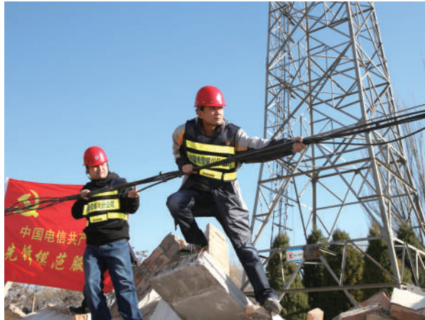
宁夏电信员工助力乡村振兴项目施工。
