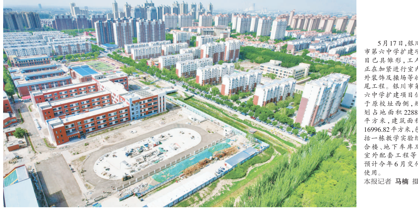
5月17日,银川市第六中学扩建项目已具雏形,工人正在加紧进行室内外装饰及操场等收尾工程。
