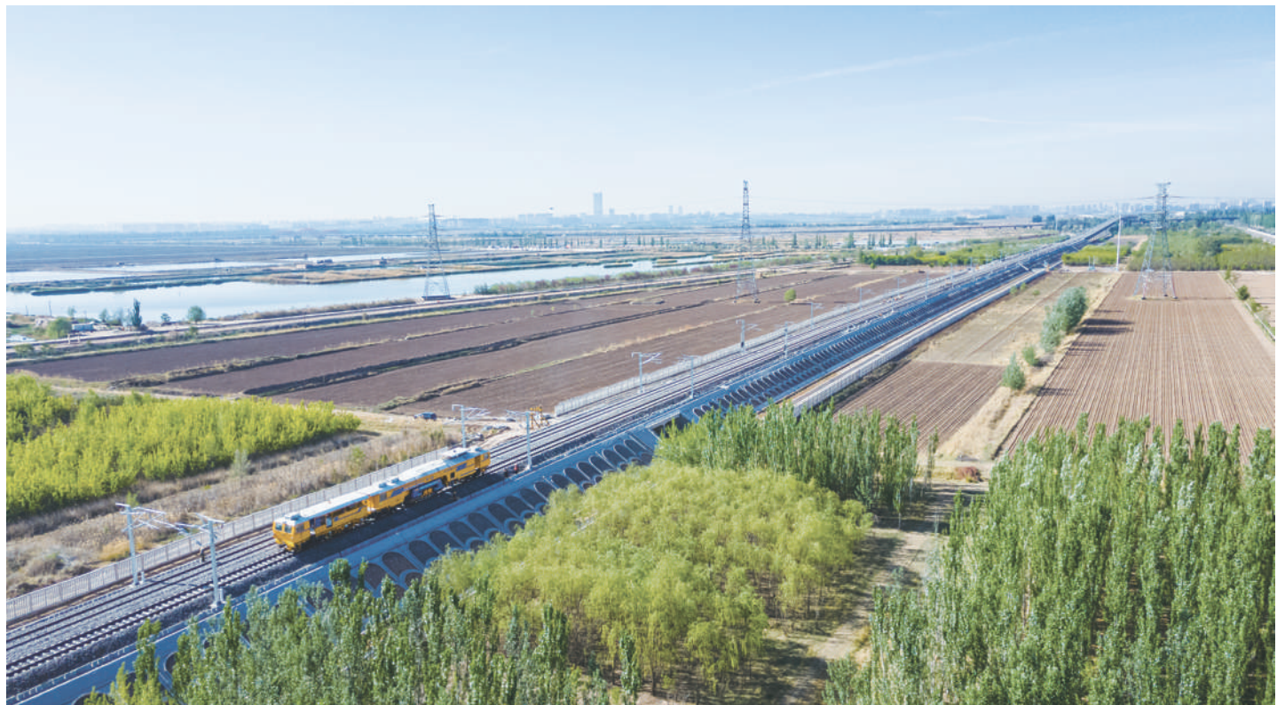
5月17日起,新建包头至银川高速铁路惠农至银川段进入静态验收阶段。图为线路大型机械车进行线路施工维修作业。(图片由中国铁路兰州局提供)
