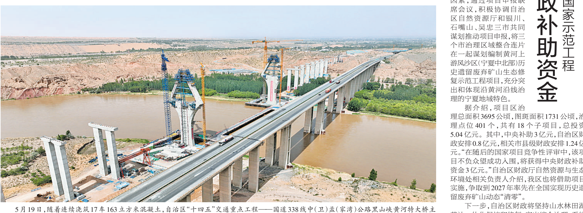
5月19日,随着连续浇筑17车163立方米混凝土,自治区“十四五”交通重点工程——国道338线中(卫)孟(家湾)公路黑山峡黄河特大桥主塔交合段完成合龙。黑山峡黄河特大桥全长1539米,是目前黄河宁夏段上塔最高、技术难度最复杂的黄河公路桥。 本报记者 赵磊 摄
