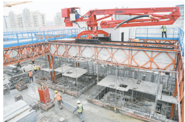
6月5日,在安徽省宿州市五一花园安置房项目现场,工作人员进行封顶作业。当日,由中建三局三公司承建的安徽省宿州市重点民生工程——五一花园安置房项目主体结构迎来全面封顶。该项目是安徽省首个采用“住宅造楼机”建设的工程项目,“住宅造楼机”施工具有智能化程度高、施工速度快等特点。新华社发
