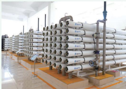
超滤纳滤膜水质提升工艺设备。
